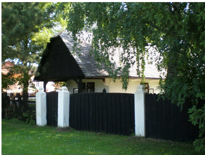
Venkovská usedlost v Dubečnu
